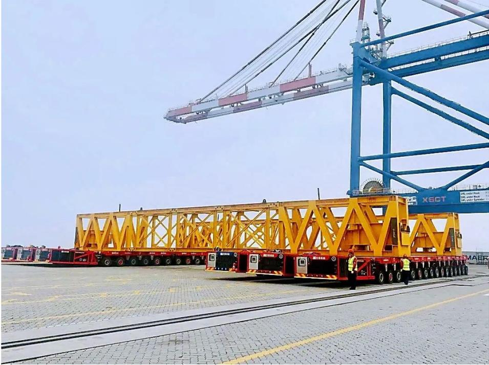
为做好此次搬迁技术支持，降低施工成本，研究总院工艺院利用现有工装设备，对承载梁进行三维建模计算后，根据实际工况采取了适应性改造，对其结构进行了加强，确保了承载梁的承载能力，减少了新梁的制作成本；同时，在确保岸桥结构强度满足移位要求的基础上，最大限度降低了现场施工量，实现降本增效。
